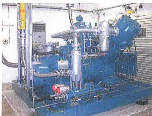
Abb. 2: Kompressorstation zur Biomethaneinspeisung
